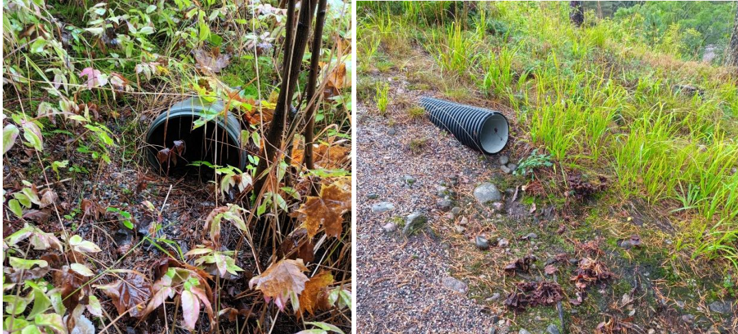
Kuva 13 ja 14. Vasemmalla Kullervontien alkupäässä oleva hulevesiviemärin purkupuutki, oikealla Kalevantien loppupäässä olevan hulevesiviemärin purkupuutki. [Ramboll 17.9.2025]
